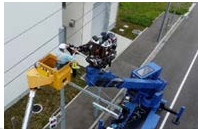
先端ロボットによる実証試験
