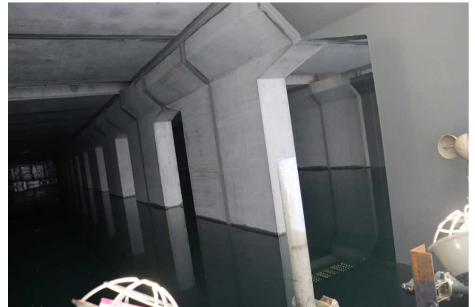
内部の状況（注水完了）
