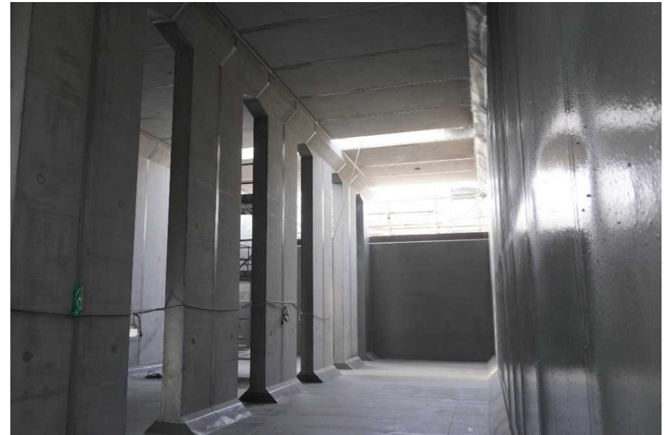
内部の状況（防水塗装完了）
