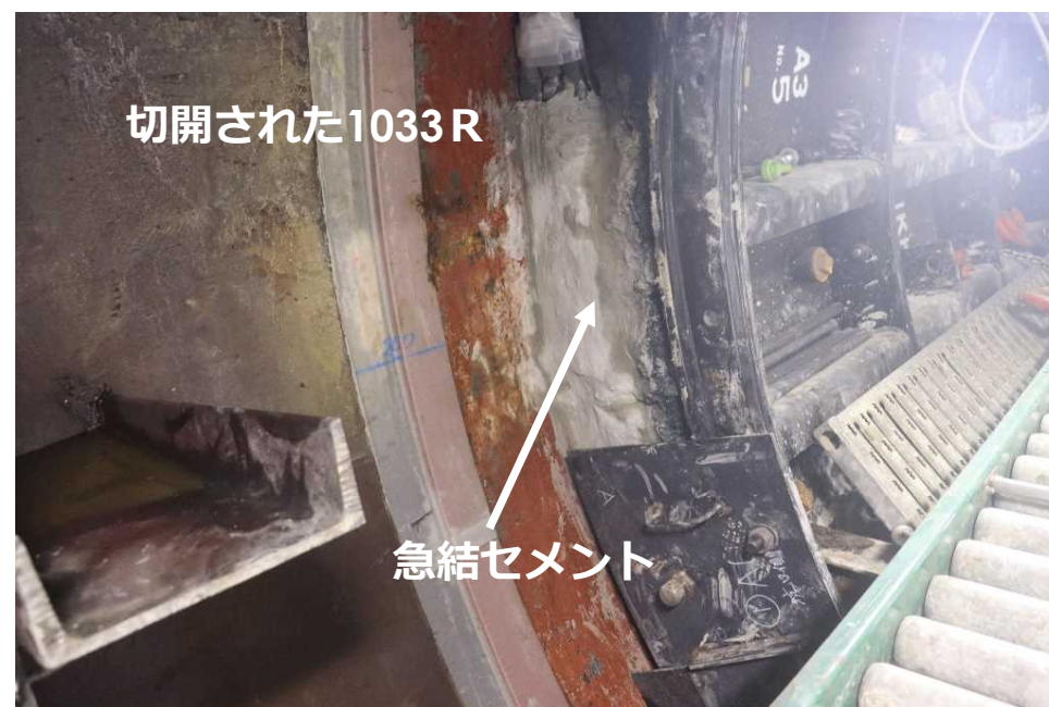
トンネル先端状況（止水工事の状況）
