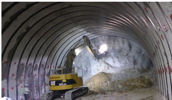
國道114号 川俣町工區關場隧道 2022年3月2日 開通
