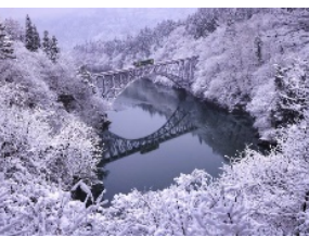
只見線鐵道設施群
