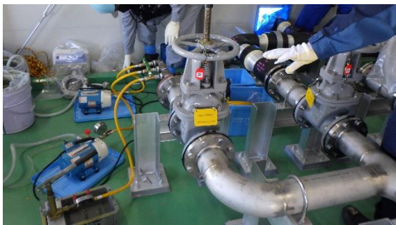
(写真2) 5、6号機東側電気品建屋内の配管 の状況
