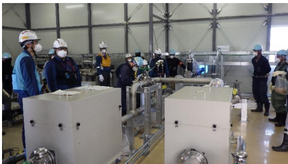
(写真5) 多核種移送設備建屋内における検査の状況
