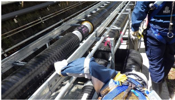
(写真4-2) 配管の検査の状況②
