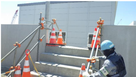
(写真1) 5、6号機東側電気品建屋の外観
