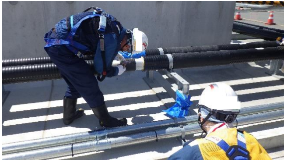
(写真4-1) 配管の検査の状況①
