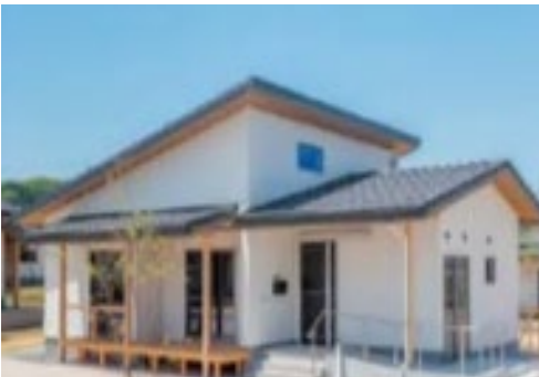
大熊町：灾害公营住宅
