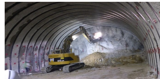
国道114号 川俣町工区关场隧道 2022年3月2日 贯通
