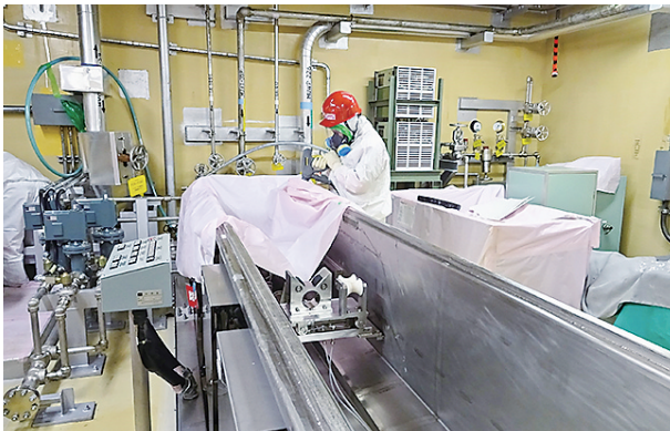
汚染の除去作業状況（東京電力提供）
