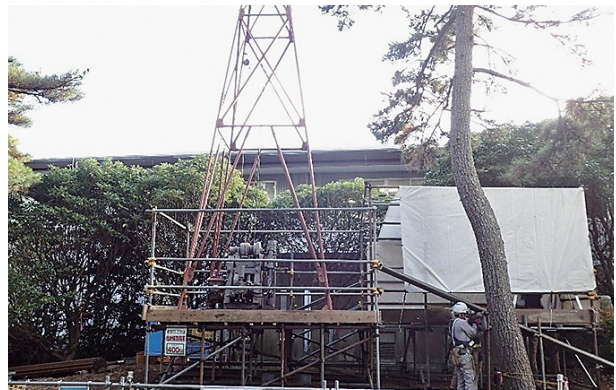
ボーリング調査の状況（東京電力提供）
