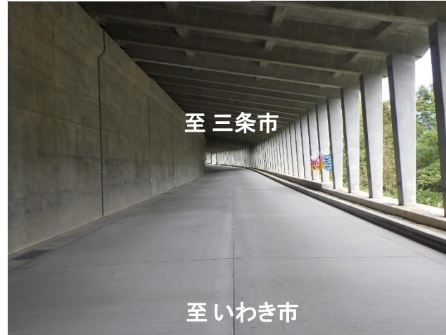
スノーシート工事状況
