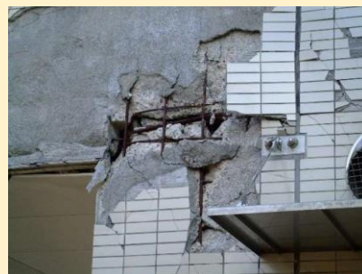
鉄筋爆裂部
