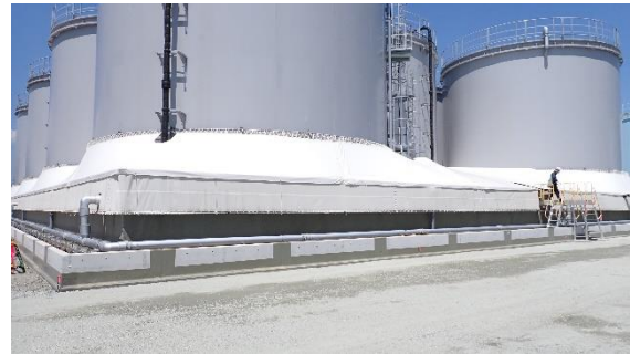
(写真1-3) G5タンクエリアの状況 (今回(令和5年7月27日)南東側から撮影)
