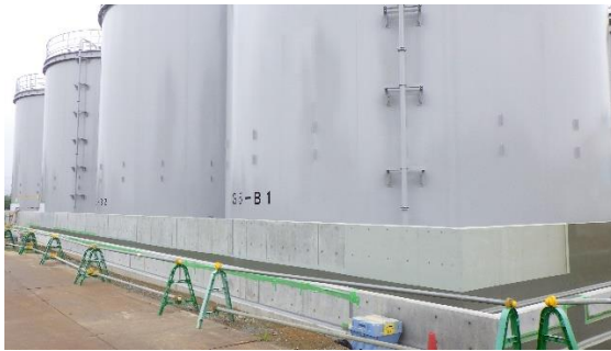
(写真1-2) G5タンクエリアの状況 (前回(令和4年7月22日)南東側から撮影)
