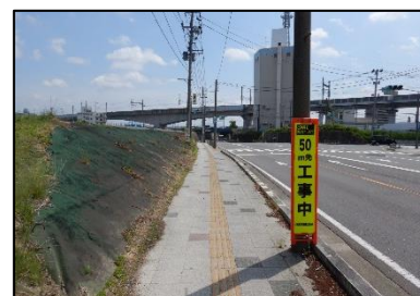
⑤堤内地状況
