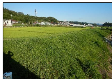
⑤堤内地状況
