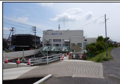
⑦梅田ポンプ場
