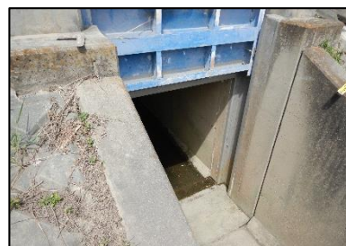
①水門町排水樋門
