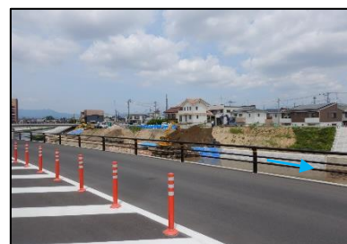
⑥逢瀬川工事状況
