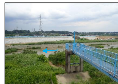
②十貫河原排水樋門
