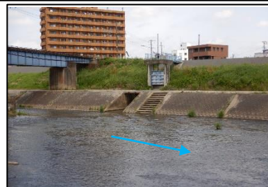
④久保田樋門
