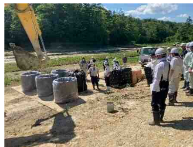
モデル事業の研修会（大型土のう製作状況）
