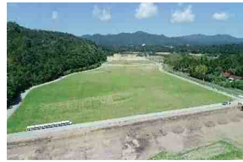
ほ場整備 矢川原地区
