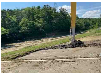
直接掘削による除去工
