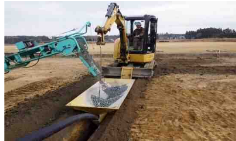
水田の汎用化に向けた暗渠排水工事
