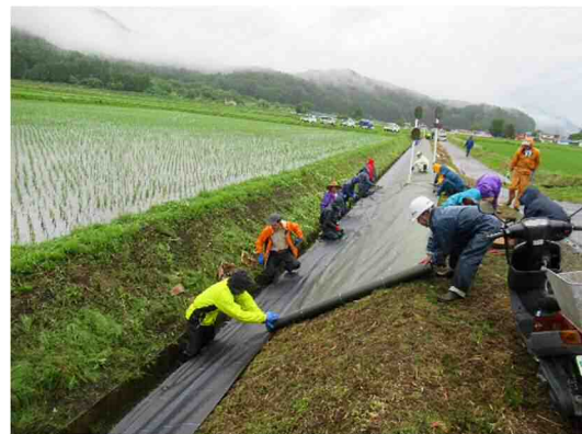
防草抑草シートの敷設活動
