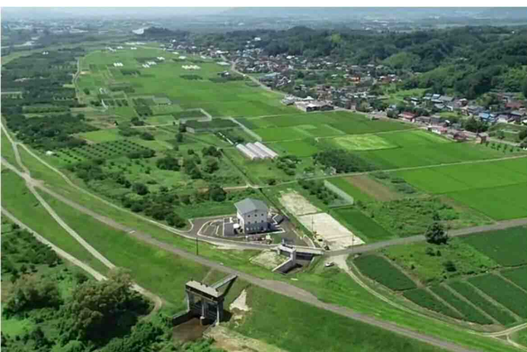
上空から五十沢排水機場・排水樋門及び受益地を望む
