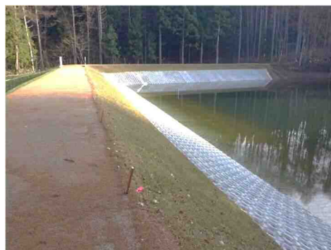
防災工事施工後
