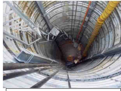
地すべり対策工事(集水井)
