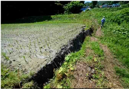
地すべり被災の農地
