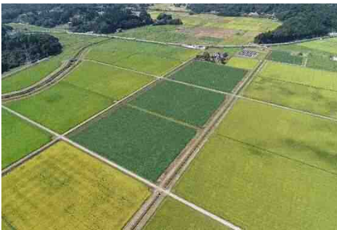
ほ場整備 西真野地区（フォアス施工）
