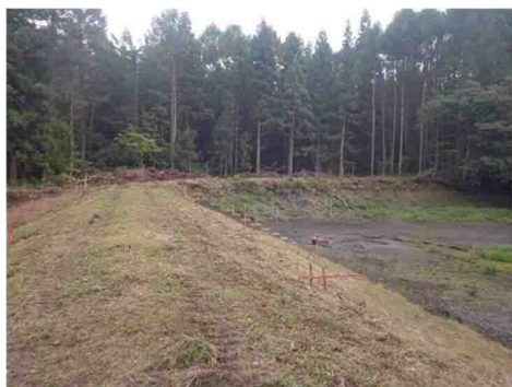
防災工事施工前
