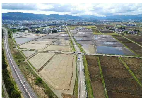
高野地区整備状況（会津若松市）
