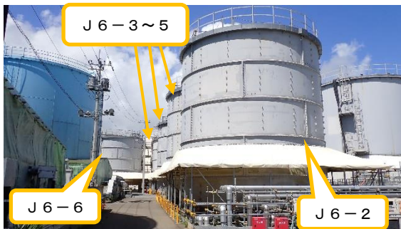
(写真4-2) J6-2~6雨水回収タンク外観(東側から撮影)
