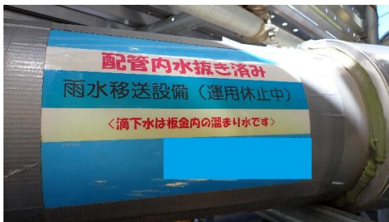
(写真4-3) J6-1雨水回収タンク付近配管における運用休止中の標示
