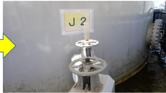
(写真3-2) J2雨水回収タンク散水払出弁の状況(今回(令和5年8月10日)撮影)
