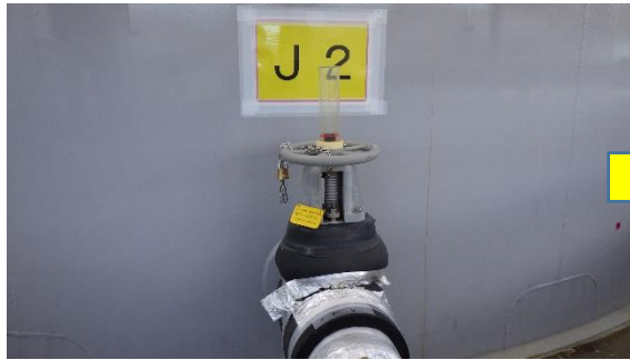
(写真3-1) J2雨水回収タンク散水払出弁の状況(前回(令和3年12月22日)撮影)
