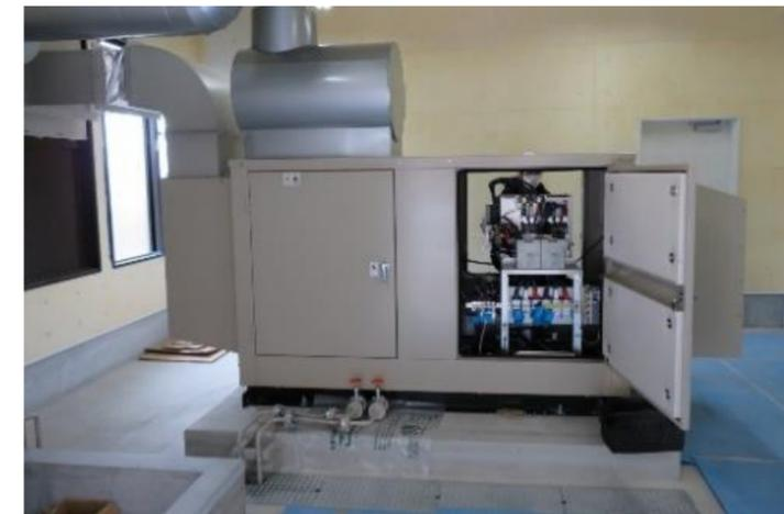
初野浄水場では、令和元年東日本台風の影響で停電が発生し、薬品による濁度管理が不能となったため、強靱化対策とし自家発電設備を設置しました。（令和4年6月末に完成）
