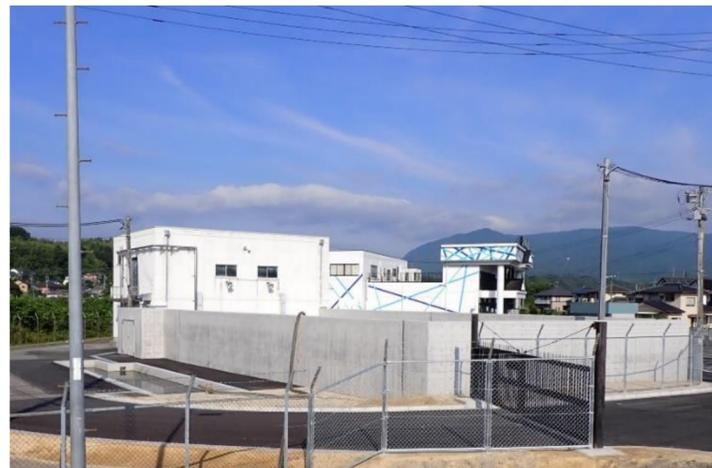
令和元年東日本台風で浸水被害を受けたため、対策工事（止水壁等）を施工しました。（令和4年8月末に完成）
