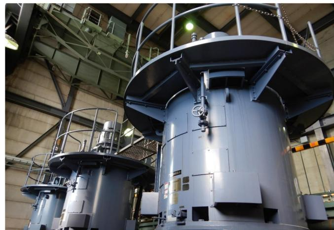
小名浜ポンプ場に設置してあるポンプ・モーターについて、経年消耗機材の交換や機器本体の点検整備・調整等を行っております。
