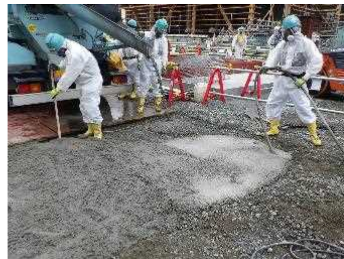
<土壌鋤取り後の捨てコンクリート打設>
