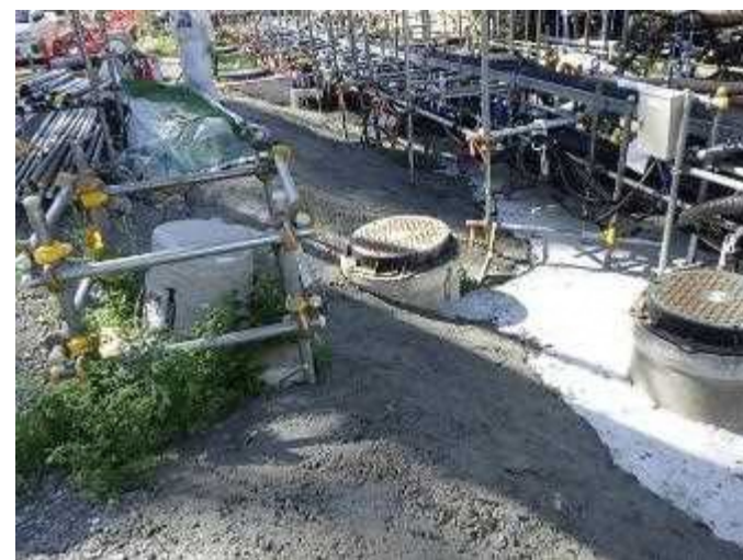
<捨てコンクリート打設後>
