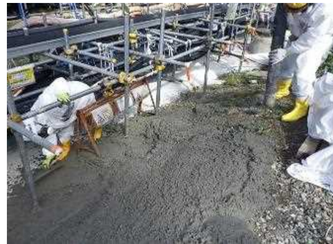
<捨てコンクリート打設状況>
