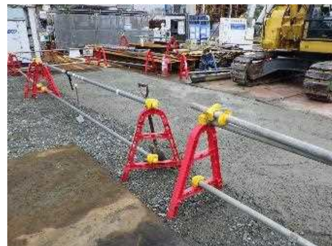
<捨てコンクリート打設後>
