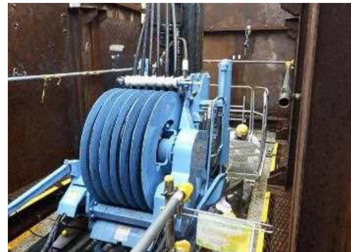
<鋼矢板打設作業状況>
