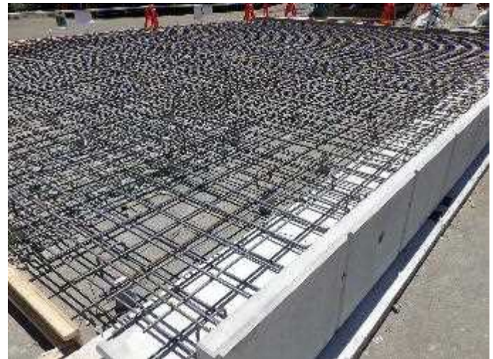
<ロールマット鉄筋敷設後>
