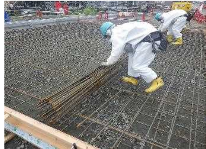
<ロールマット鉄筋敷設状況>
