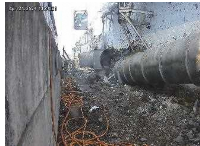
<飛散防止剤散布状況>
