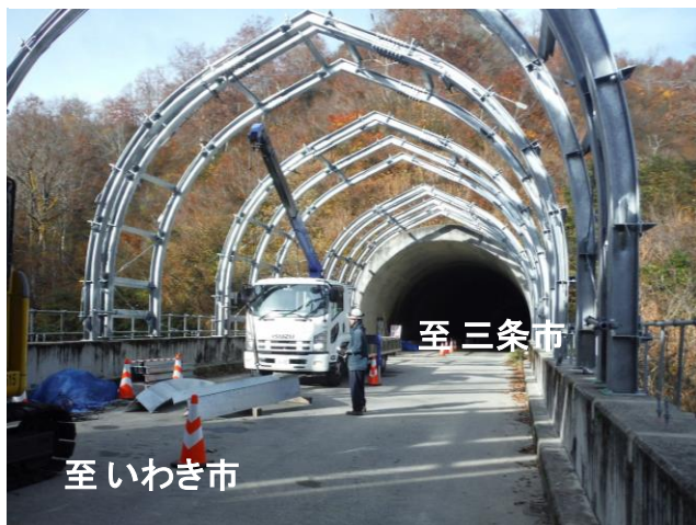
ナコ沢スノーシェルター工事状況
