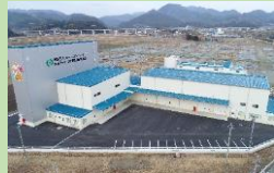
営農再開に向けた施設整備
