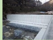
老朽化した頭首工の補修
