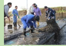
地域ぐるみでの堰の土砂上げ作業
