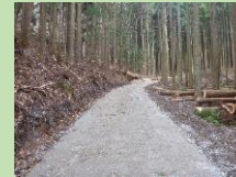
森林作業道の開設
