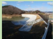
老朽化したため池の改修
