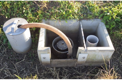
フォアス給水(ほ場の水口)
