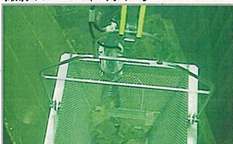
落下がれき撤去作業 撮影日：2013年9月下旬
