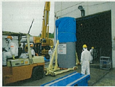
ベッセル搬入状況
