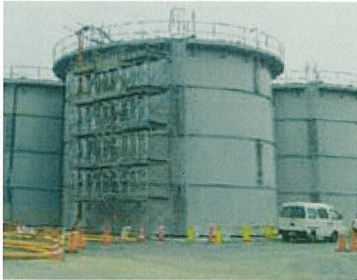
鋼製円筒型タンク (フランジ接合)
