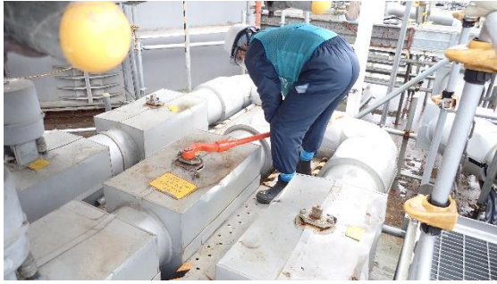
(写真3-1) グループ1排水弁の「全開」作業状況
