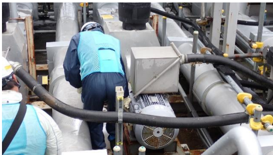
(写真4) ポンプ起動後の確認状況
