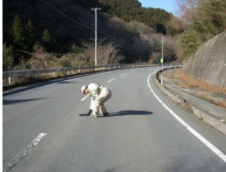
落下物撤去作業
