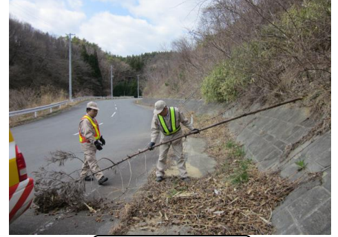
支障枝処理作業
