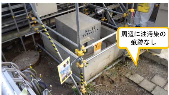
(写真1-2) サブドレンピットNo.19の状況
