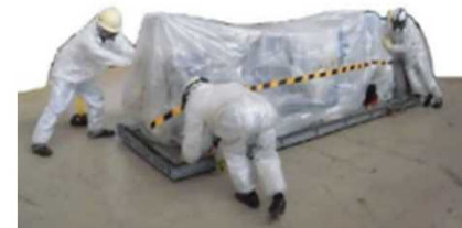
堆積物除去装置 （高圧水、AWJ）撤去
