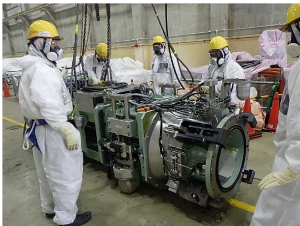
堆積物除去装置 (低圧水) 外観
