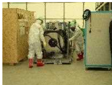
堆積物除去装置 （高圧水、AWJ）設置
