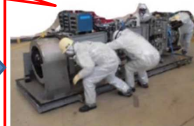
堆積物除去装置 （低圧水）撤去
