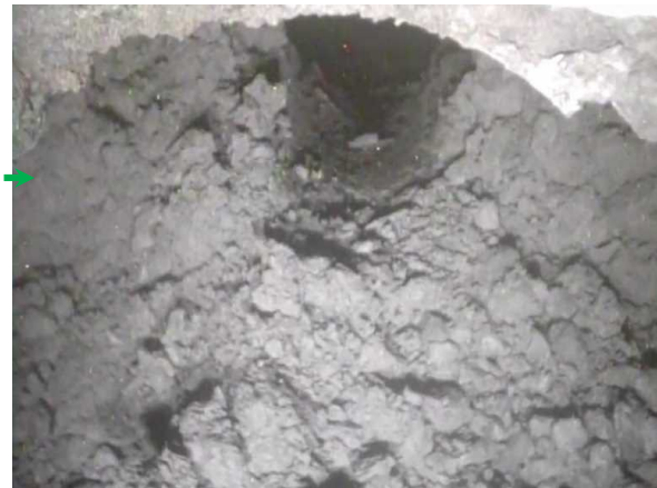
低圧水施工前 1月17日作業開始前
