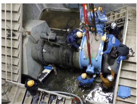
猪取頭首工バタフライ弁更新工事
