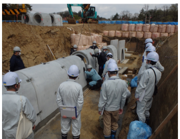
底樋(プレキャスト)の設置
