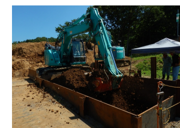
盛土材の試験混合
