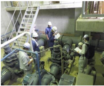
▲点検の様子 遠田貝沼揚水機場（喜多方市）
