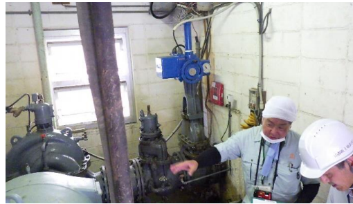
▲点検の様子 堰沢揚水機場（喜多方市）
