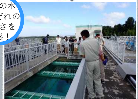
大野台浄水場 真野ダムから流れ着いた水 が、おいしい水道水に！
