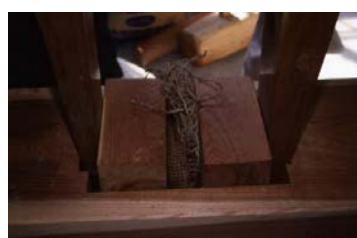
⑤カタの間に麻袋を挟み、ヤを差し込み掛け矢で打ち込む
