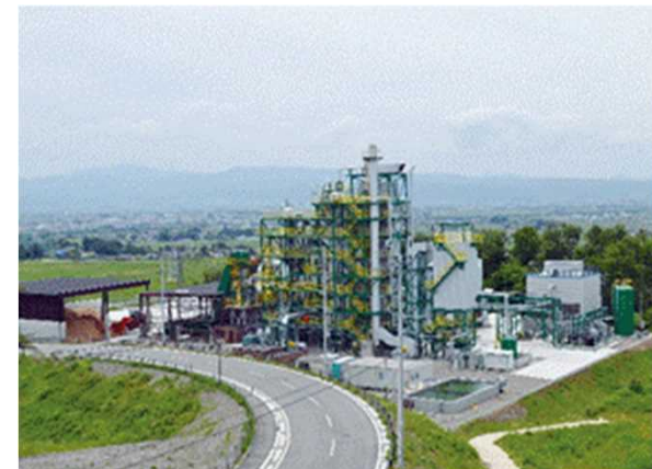
写真：木質バイオマス発電所（提供：(株)グリーン発電会津）
