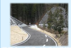
整備中の林道（永井川前線）
