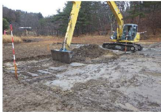
（例）ため池底質の掘削除去状況
