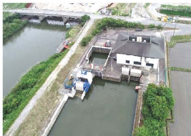
ざわみき 沢帯排水機場（いわき市）
