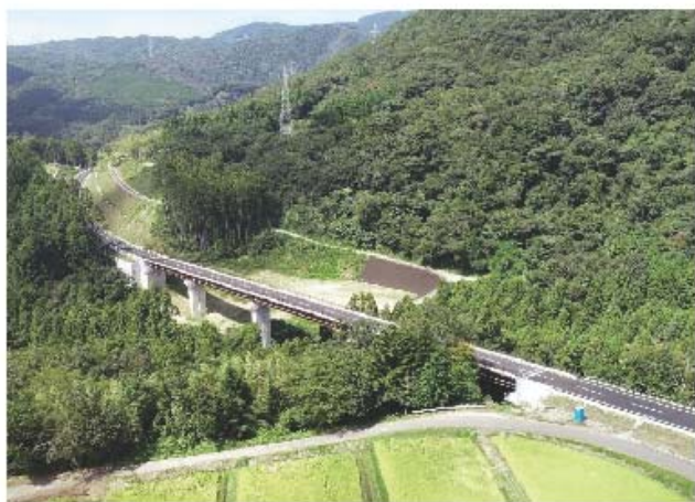
広域農道整備事業 いわき地区（いわき市）
