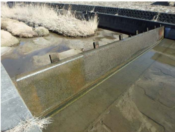
塗装が剥離している堰を補修（田村市）
