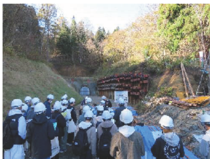
ふくしまの農村学びの場 工事現場見学会
