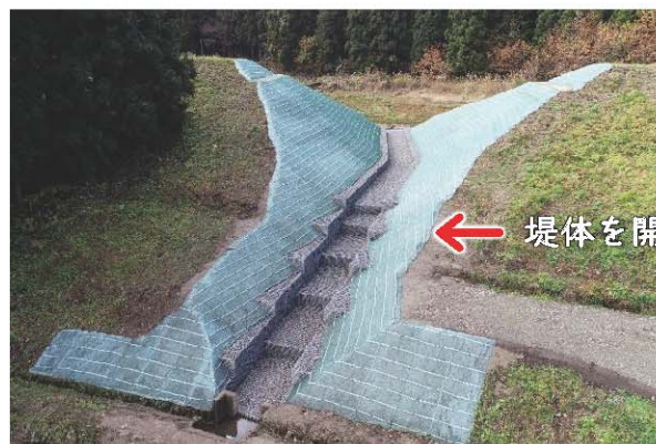
ため維持管理事業（ため池廃止） 赤館地区（会津美里町）
