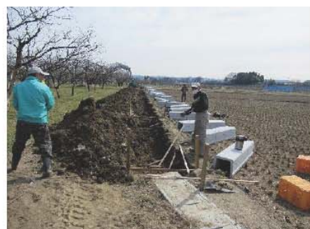
直営施工による水路整備
