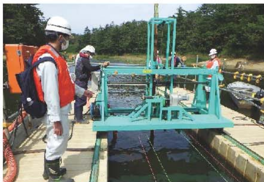
（例）ポンプ浚渫による除去状況
