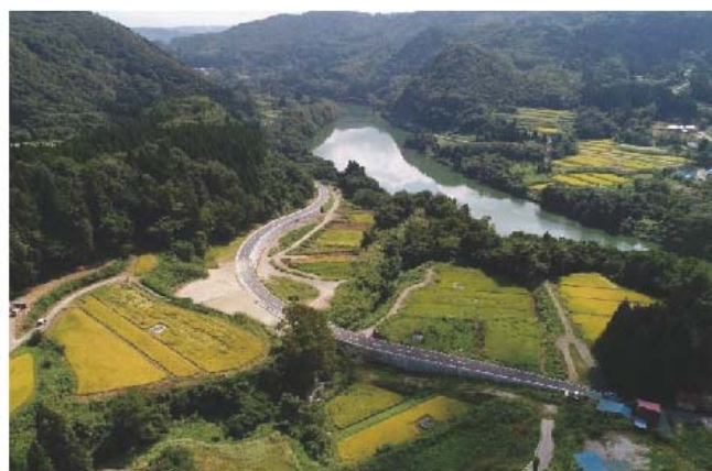
地すべり対策事業 あがつ 揚津地区（喜多方市）
