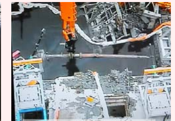
燃料交換機マスト撤去 (H26.3.27)
