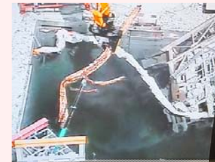
屋根トラス撤去(H26.3.28)
