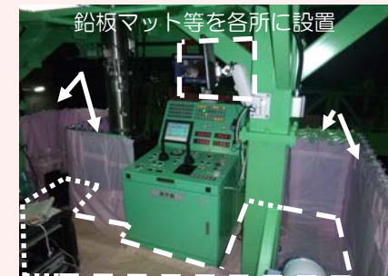
② 燃料取扱機上の操作盤まわりを、遮へい材で囲い、操作する作業員の被ばくを低減
