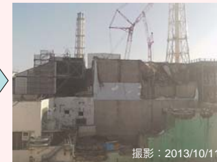
大型ガレキ撤去後
