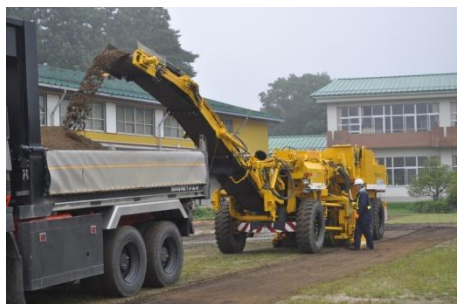
▲路面切削機を用いた表土除去作業の様子
