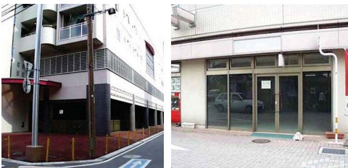
公営住宅の併設店舗の例 (別府市HPより)
