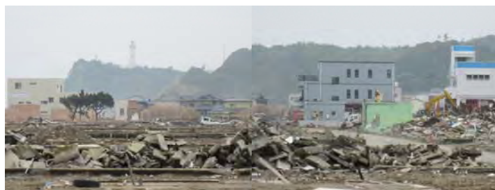
薄磯地区被災状況
