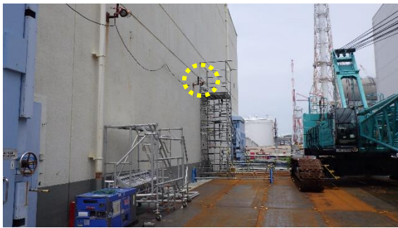
(写真1①) 追設水素ベント口 (HTI 建屋)
