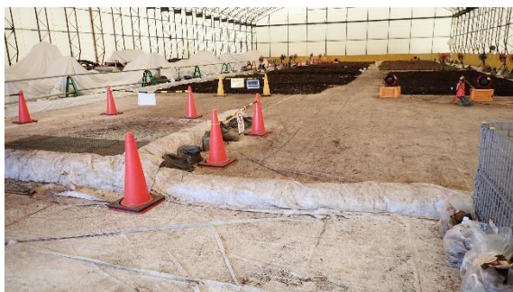
(写真4) 堰の設置状況
