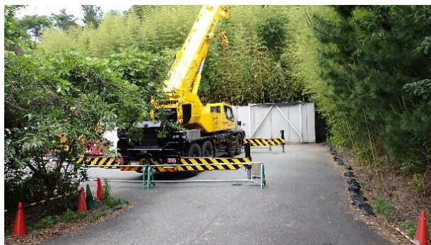
(写真2) ラフタークレーンの配備状況 (北側を向いて撮影)
