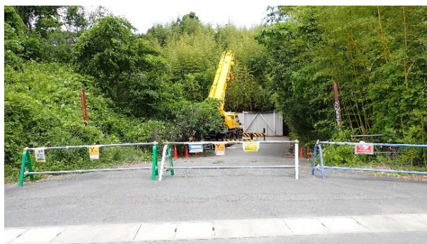
(写真4-1) 一時保管エリアE2の状況 (北側を向いて撮影)
