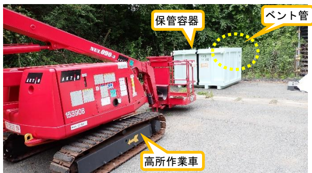
(写真3-1) 高所作業車及びベント管が取り付けられた保管容器 (西側を向いて撮影)
