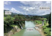
桁架設及び軌道工事完成
