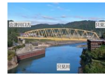
桁架設及び軌道工事完成
