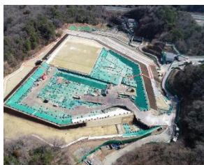
特定廃棄物埋立処分施設
