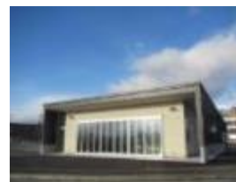
猪苗代水環境センター
