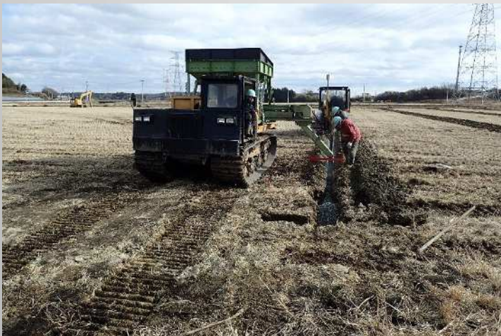
▲担当現場での暗渠布設の様子
