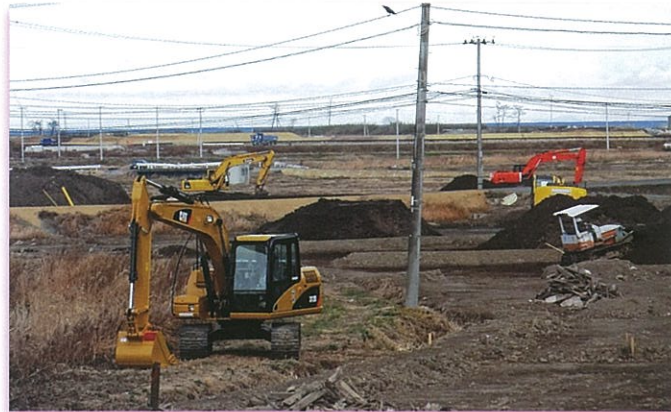
農地の復旧工事も本格的に始まっています。
