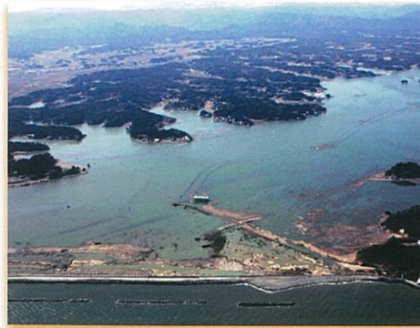
約350haが水没した八沢地区 (相馬市・南相馬市)
