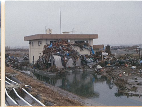
ガレキが押し寄せた 芹谷地排水機場 (相馬市)
