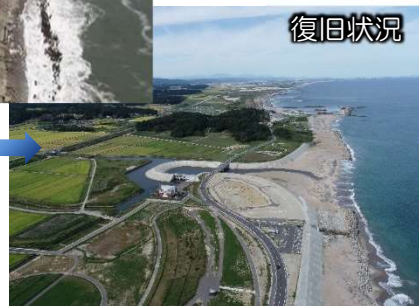
①東日本大震災 の復旧状況
