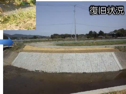
②令和5年台風13号 の復旧状況
