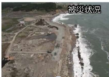
木崎地区海岸（新地町）
