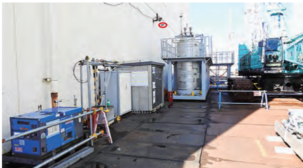
放射性物質を含む水が漏えいした箇所 (写真の赤い丸が水が漏えいした配管)
