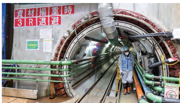
ALPS 処理水希釈放出設備 放水トンネル
