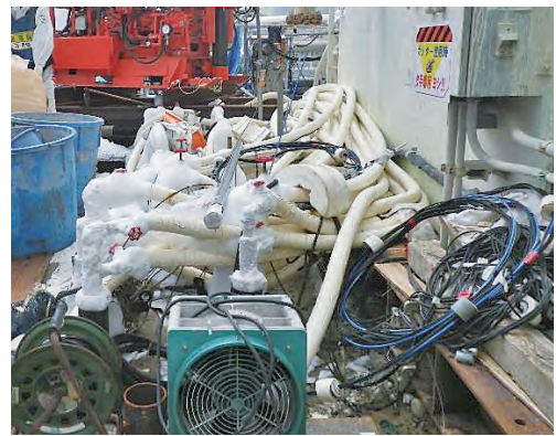
2号機海水配管トレンチ止水工事状況
