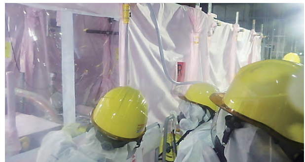
対策（ホース固縛等）の確認状況
