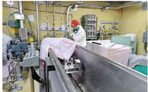
汚染の除去作業状況（東京電力提供）
