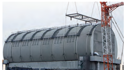
3号機燃料取り出しカバー
