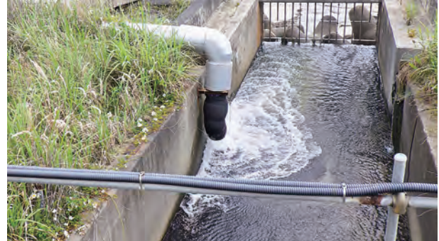
地下水バイパス排水状況
