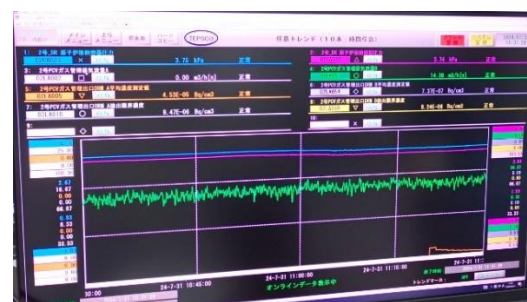
(写真4) 使用前検査中のプラントパラメータの状況
