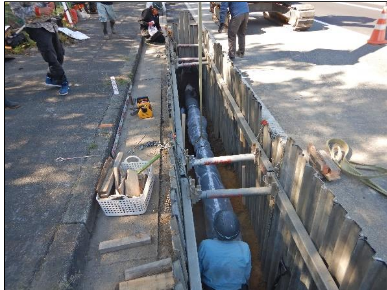
管路更新事業（配水管）
