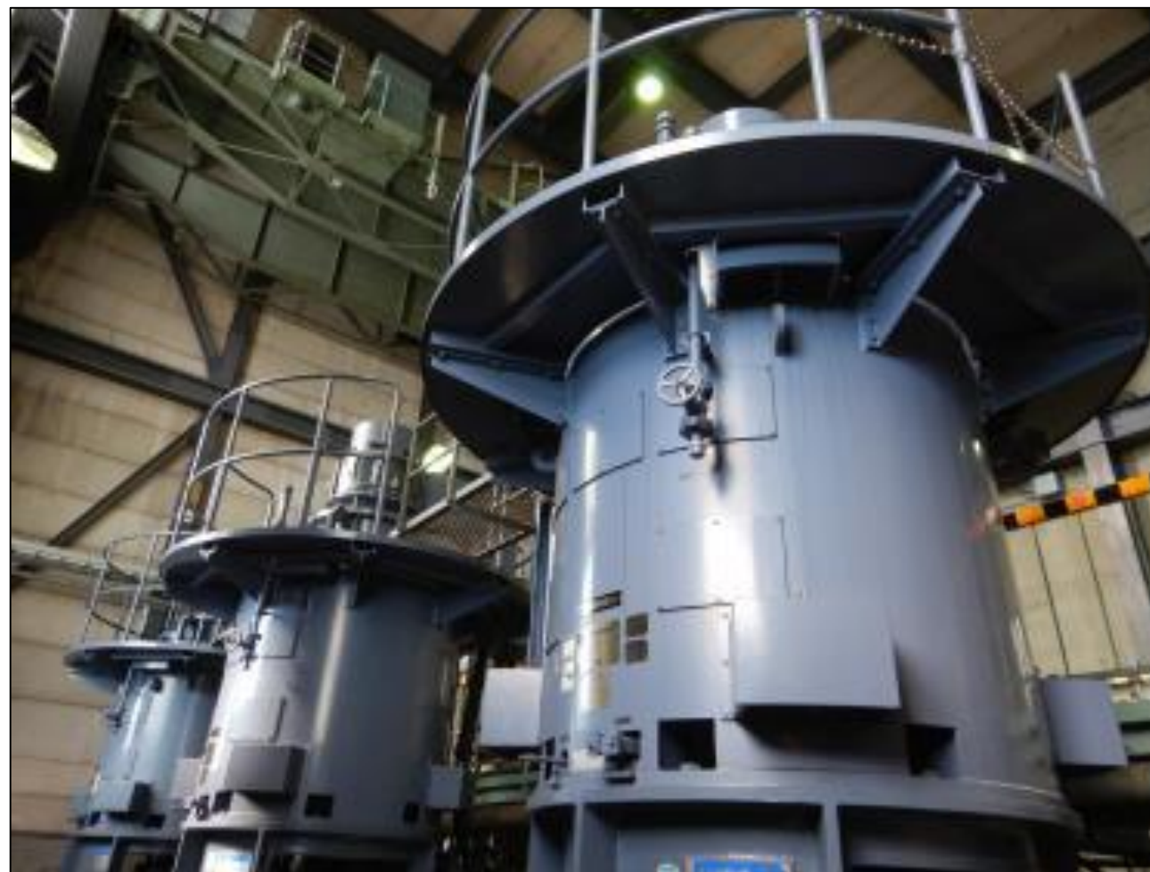
ポンプ・モーターの高効率化更新事業
