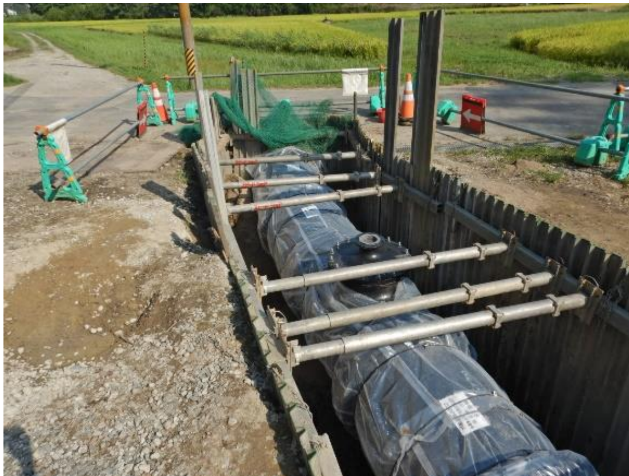
管路更新事業（導水管）
