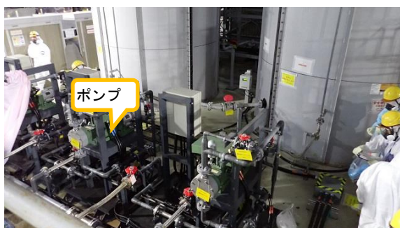
(写真2-2) 塩酸供給設備ポンプのメンテナンス 状況②
