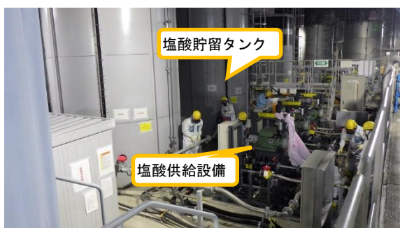
(写真2-1) 塩酸供給設備ポンプのメンテナンス 状況①
