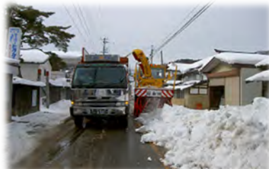
除雪（排雪）中状況
