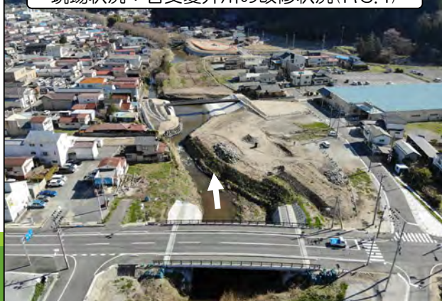
現場状況：右支夏井川の改修状況(R6.4)
