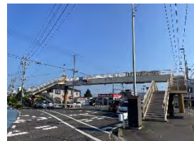
あさか歩道橋 橋梁補修完了
