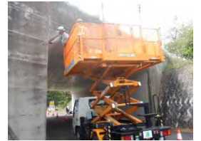
松ノ中ボックスカルバート 点検状況
