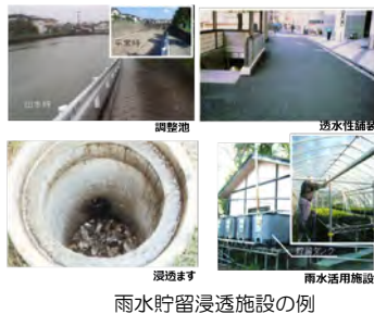
雨水貯留浸透施設の例
