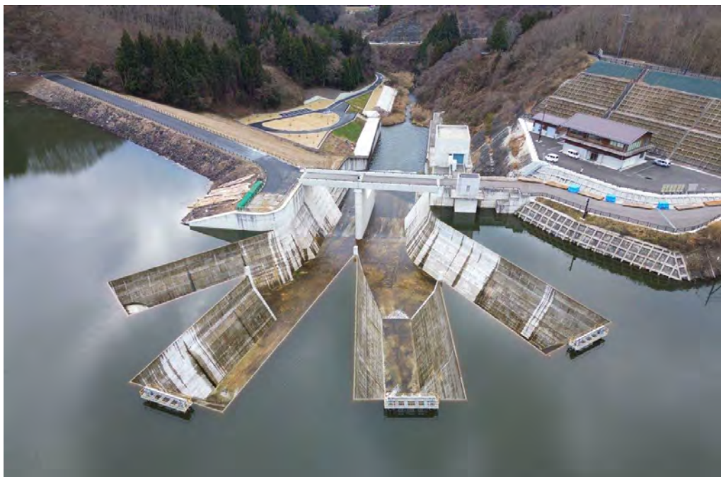
千五沢ダム ラビリンス型洪水吐部 試験湛水状況(写真は満水時)
