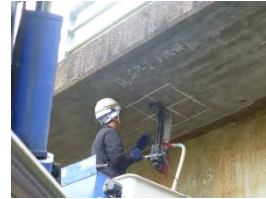
舟津橋 点検状況
