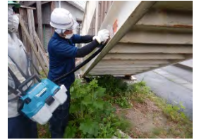
原歩道橋 点検状況
