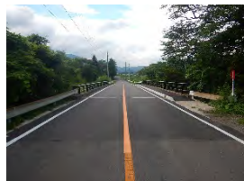
坂口橋 橋梁補修完了
