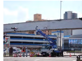
わかば歩道橋 点検状況
