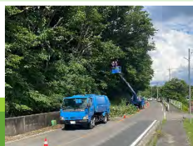
道路支障木伐採
