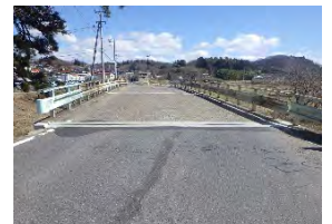
守谷橋 橋梁補修完了
