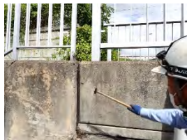
熱海歩道橋 点検状況
