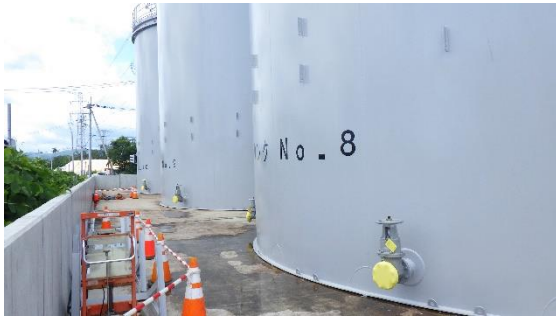
(写真3-2) 設置が完了したタンクの状況② (集水タンクエリア南端部 溢水防止用堰の設置を完了)
