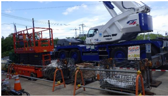
(写真4) 資機材の保管管理状況
