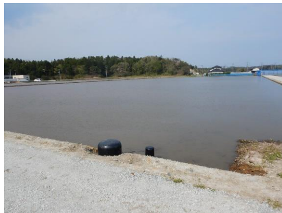
八沢地区における自動給水栓設置状況 (南相馬市鹿島区)
