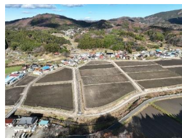
北移地区におけるほ場整備後の状況 (田村市船引町)
