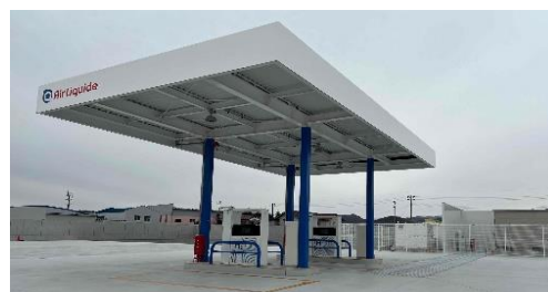
本宮インターチェンジ水素ステーション
